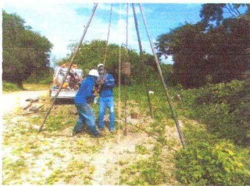
Foto 03 – Detalhe da operação de cravação do amostrador padrão para obtenção do "SPT" do terreno de fundação.
