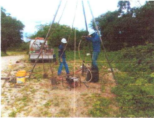
Foto 05 – Detalhe da operação de lavagem para atingir a cota de amostragem do furo de sondagem.
