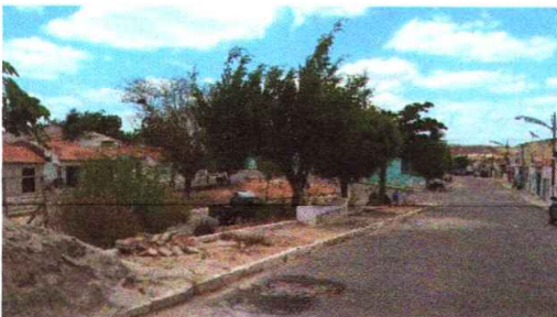
Local da obra da praça
