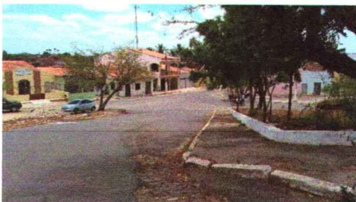
Local da obra da praça
