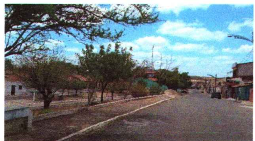
Local da obra da praça
