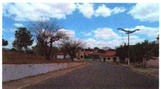
Local da obra da praça
