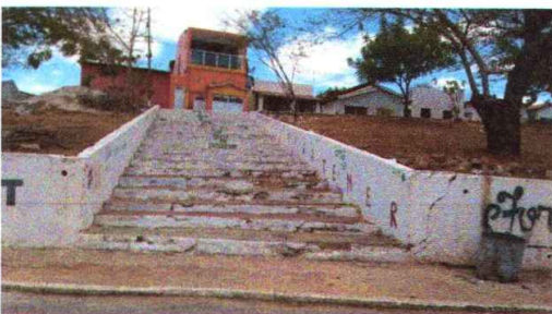
Local da obra da praça
