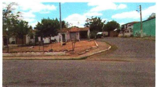
Local da obra da praça
