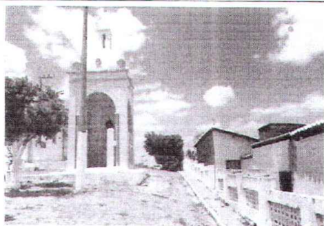
Espaço para revitalização
